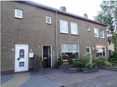
De Ruyterstraat 51 te Maasdijk
